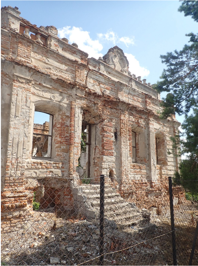
FOT. 1, 2 Elewacja południowa -attyka, silne spękania pionowe i ukośne, korona muru pozbawiona zabezpieczenia
