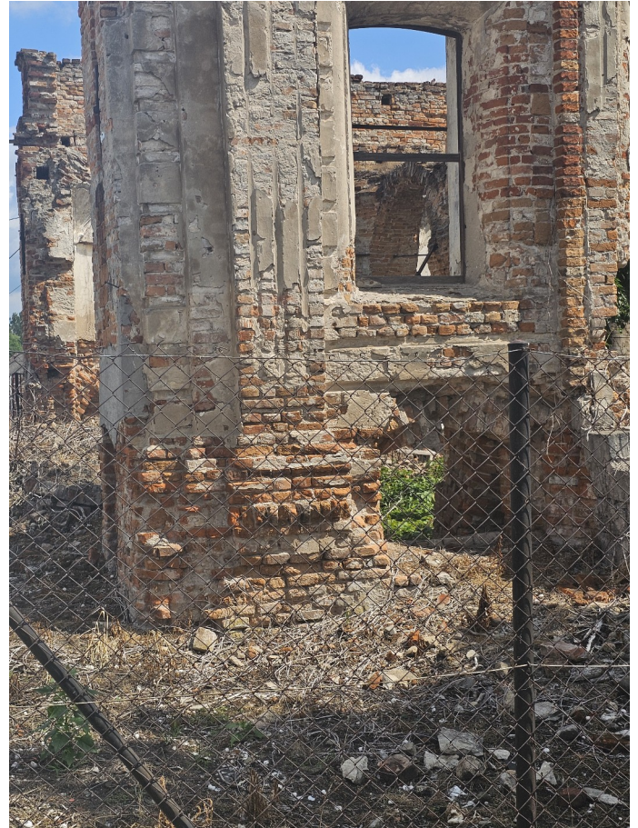
FOT. 1, 2 Elewacja południowa -attyka, silne spękania pionowe i ukośne, korona muru pozbawiona zabezpieczenia
